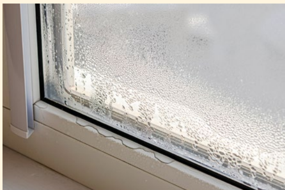
Typisches Kondenswasser auf dem Fensterrahmen © Nataliia Yankovets/Shutterstock
